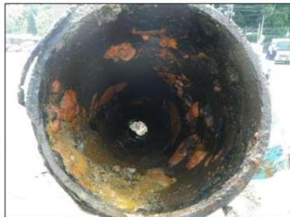
H28 下福井 φ 350 施工
