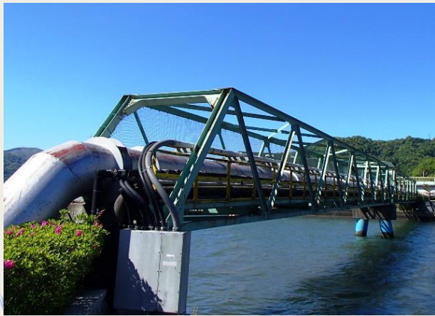
築50年以上経過した水管橋
