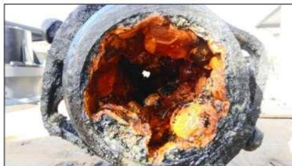
H28 大内野 φ 150 施工
