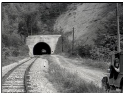
昭和35年頃の吉野トンネル
