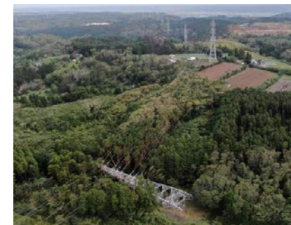
鉄塔設備の倒壊（君津市）
