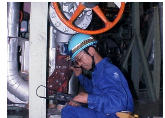
配管の厚み点検
