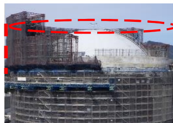
<外部遮蔽壁頂部の撤去> 2017.7~
