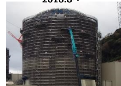
<上部鉄骨の組立> 2018.8~
