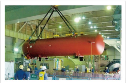
高圧給水加熱器の取替え
