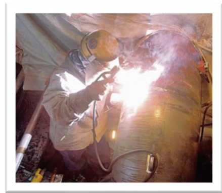
配管の取替え
