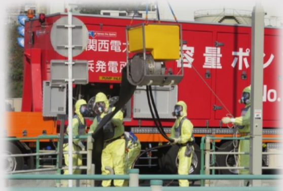
<大容量ポンプ接続訓練>
