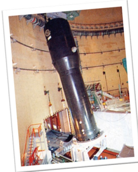
蒸気発生器の取替え
