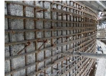
<外部遮蔽壁の補強> 2017.10~
