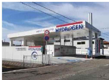
【定置式水素ステーション】
