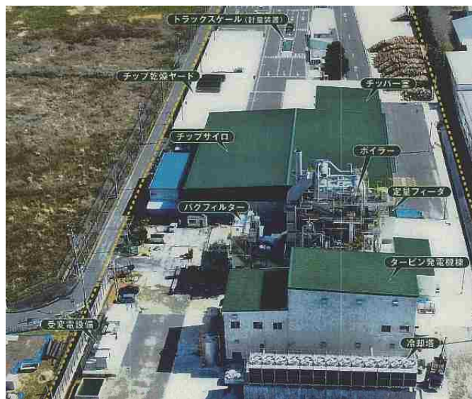
図 4-8. 木質バイオマス発電所とチップ工場
