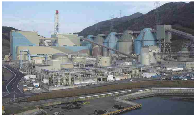
図 4-7. 関西電力株式会社舞鶴発電所
