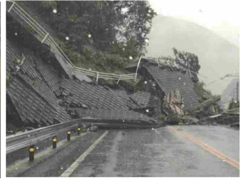
平成 30 年 7 月豪雨 平成 30 (2018 年) 年 7 月 5 日～7 日 (国道 27 号土砂崩れ 真倉地区)
