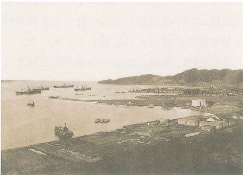
西港修築工事
