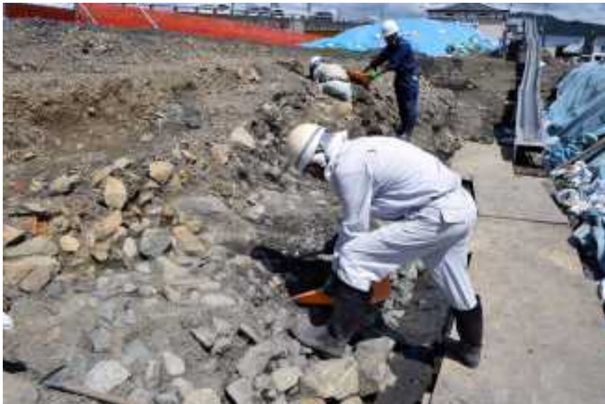
石垣 1 裏込石検出作業風景 (西から)
