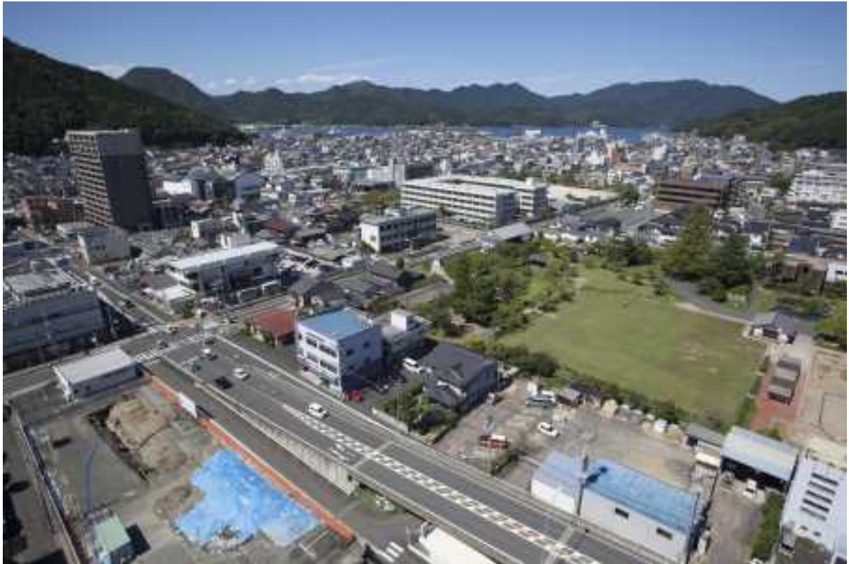
調査地遠景（南東から）
