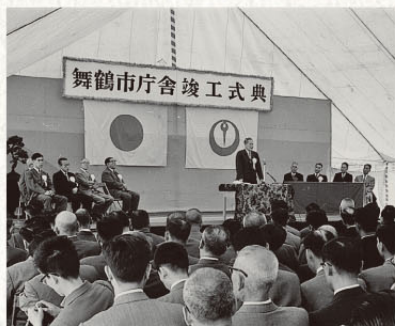
市庁舎竣工式典 昭和38年
