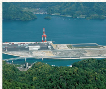
舞鶴国際ふ頭完成 平成22年
