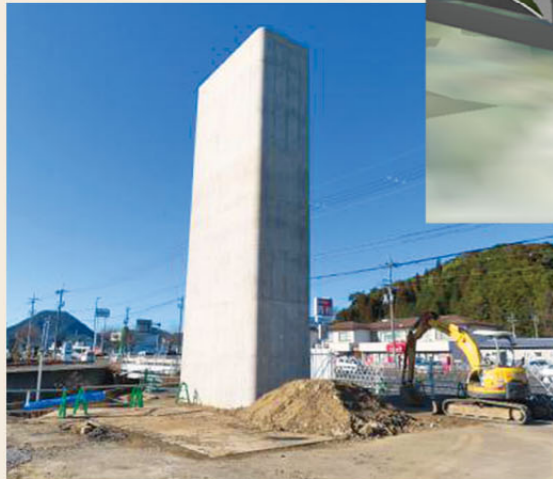
▲PBI橋脚工事（舞鶴港湾事務所提供）
