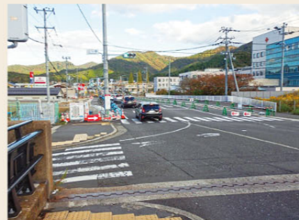
▲道路築造工事（倉谷工区）
