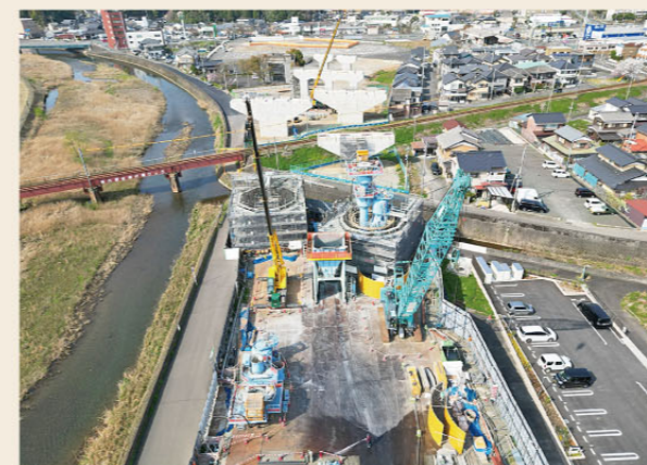
▲上安久高架橋橋脚工事（福知山河川国道事務所提供）
