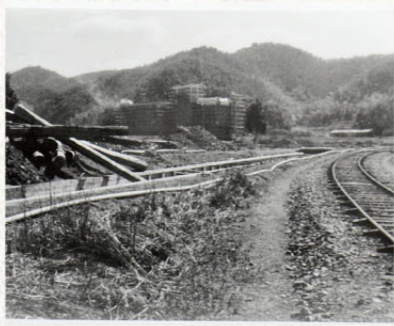
建設中の舞鶴工業高等専門学校 昭和40年
