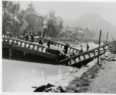
台風13号で壊れた万代橋 昭和28年
