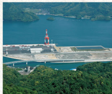
舞鶴国際ふ頭完成 平成22年
