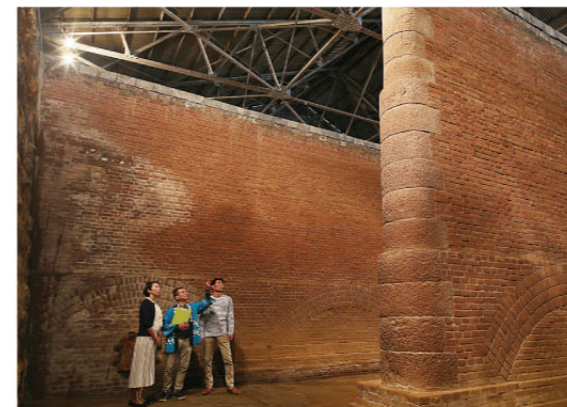
▲北吸浄水場配水池内部
