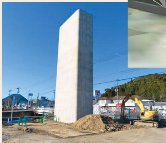
▲PBI橋脚工事（舞鶴港湾事務所提供）
