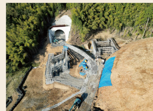
▲境谷トンネル坑口付近（福知山河川国道事務所提供）
