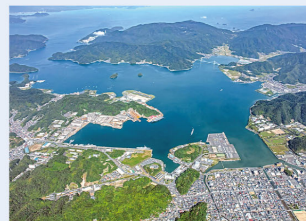
▲最近の東港全景（近畿地方整備局舞鶴港湾事務所提供）
