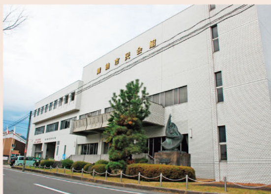
▲閉館した市民会館
