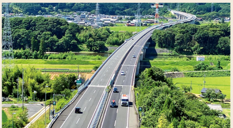
▲由良川橋 (福知山～綾部間) (京都府提供)
