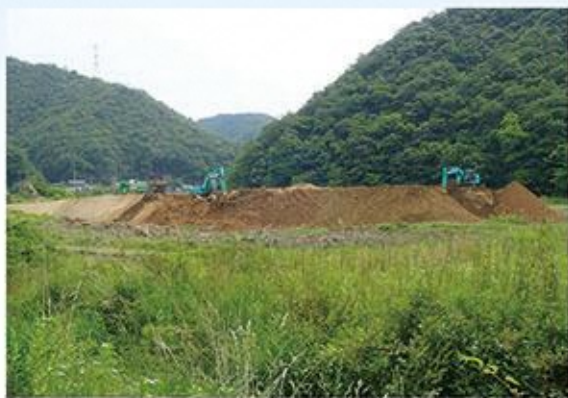
圃場の中に積み上げられた基盤整備用の土砂
