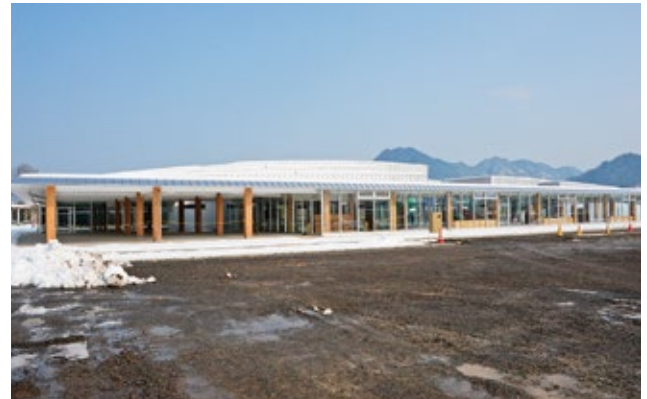
▲建設中の子育て交流施設(2月12日撮影)
