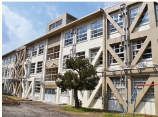
▲新舞鶴小の南舎の耐震化や内装を改修
