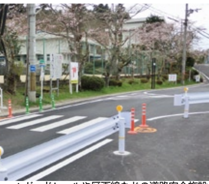
▲ガードレールや区画線などの道路安全施設を整備
