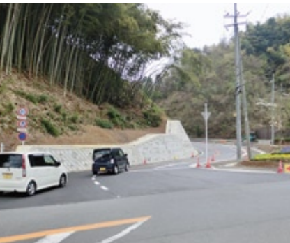
▲市道北吸森線を拡幅整備
