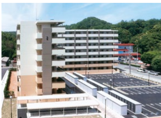
▲建て替えを進めている市営三宅団地
