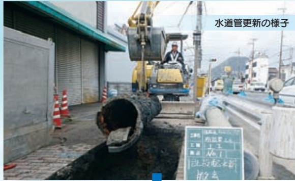
▲老朽化した铸铁管を撤去
