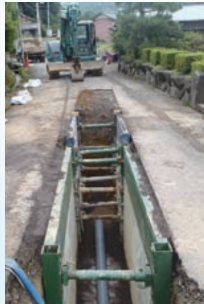
▲下水道管の布設
