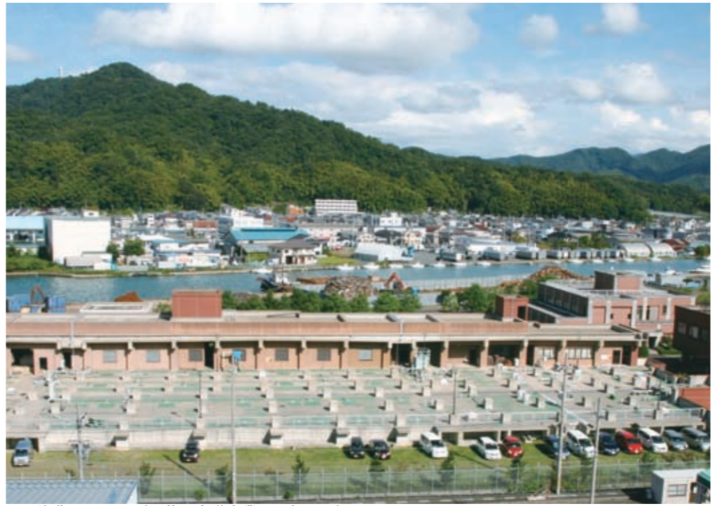
▲西浄化センター (公共下水道事業・西処理区)
