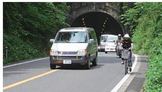
▶現在のトンネル付近は、幅員が狭く歩車道が分離されていないため危険
