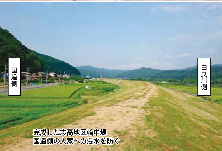
下東地区で進む工事 (写真=福知山河川国道事務所提供)
