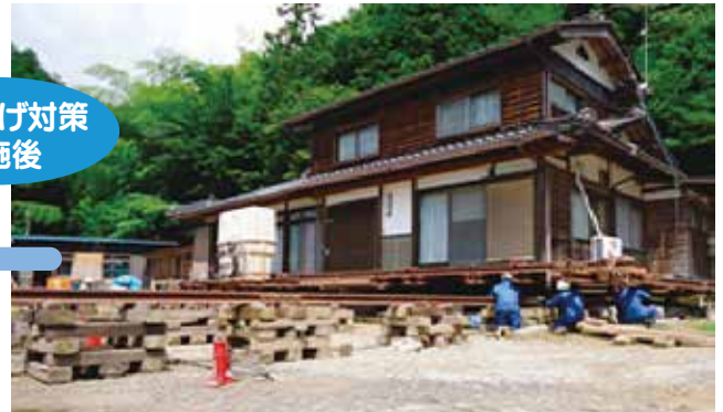
▲地盤を高くする宅地かさ上げ工事の様子。過去の洪水水位を基に算定した高さ(計画高水位)以上に施工。
