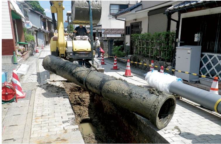
▲水道管の更新工事
