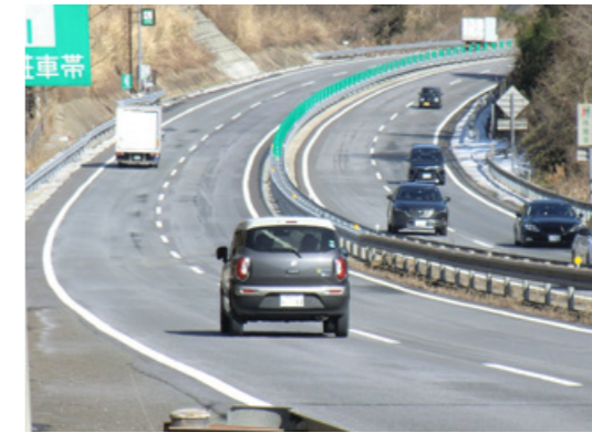
舞鶴若狭自動車道 4車線化事業
