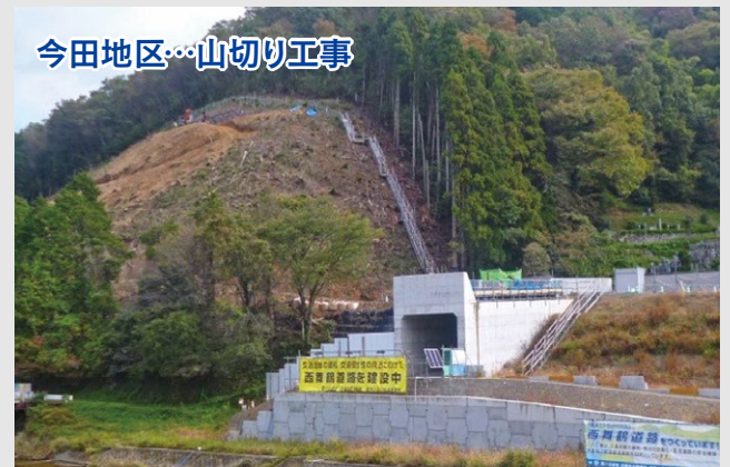
今田地区…山切り工事 道路予定地にかかっている山を切り取る工事が進んでいます。
