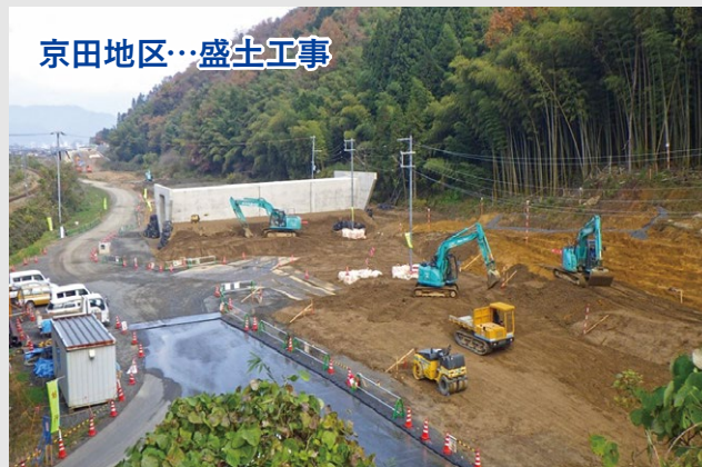
京田地区…盛土工事 現在の地面より高い位置に道路が通るため、土を盛っています。
