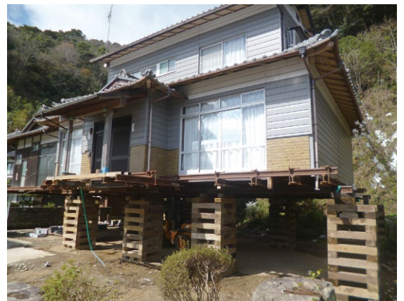
▲かさ上げ工事中の住宅
