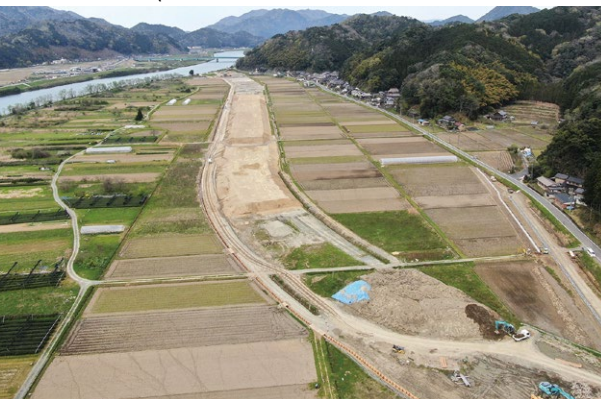
▲三日市輪中堤 (国土交通省福知山河川国道事務所提供)
