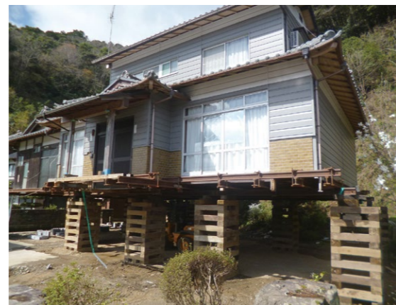
▲かさ上げ工事中の住宅
