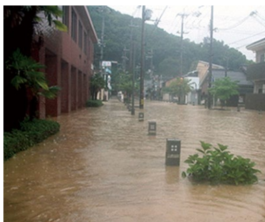
▲水害の様子(平成30年、堀上)
