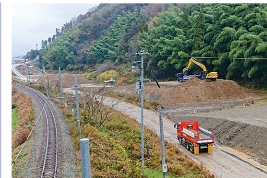
▲盛土工事 (京田)
