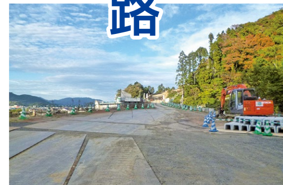
▲切土・擁壁工事 (今田)
