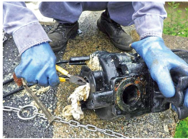
▶ポンプに詰まったハンカチを取り出す様子
