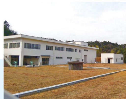
▲上福井浄水場 場内整備
