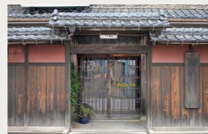
茶又旅館 門及び塀 1棟 【所在地】舞鶴市字本 【建築年代】昭和25(1950)年 主屋の前面、道路境界に沿って 建つ。朱色の漆喰塗で格子付小窓 を設け、通りの景観を形成する。
