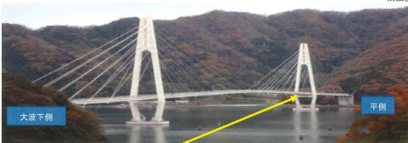
舞鶴クレインブリッジ 支承損傷箇所
