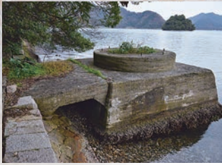
▲重機の基礎と思われる構造物
