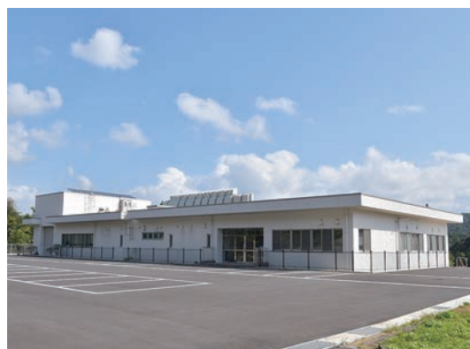
▲完成した上福井浄水場管理センター
