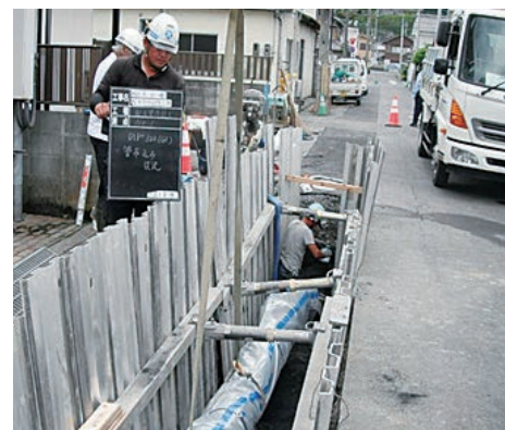
▲耐震性・耐久性の優れた管路に布設替え
