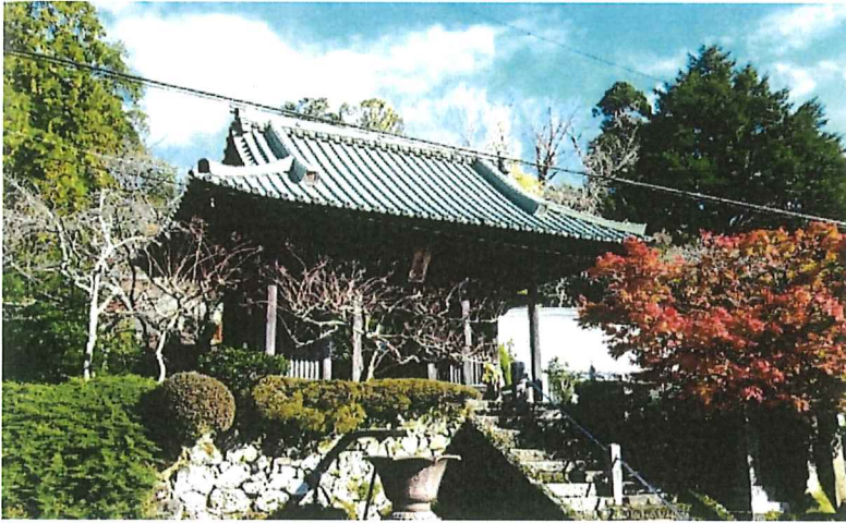
仁王門（解体修理前）
