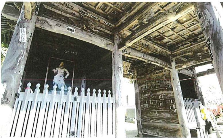
仁王門（解体修理前）
