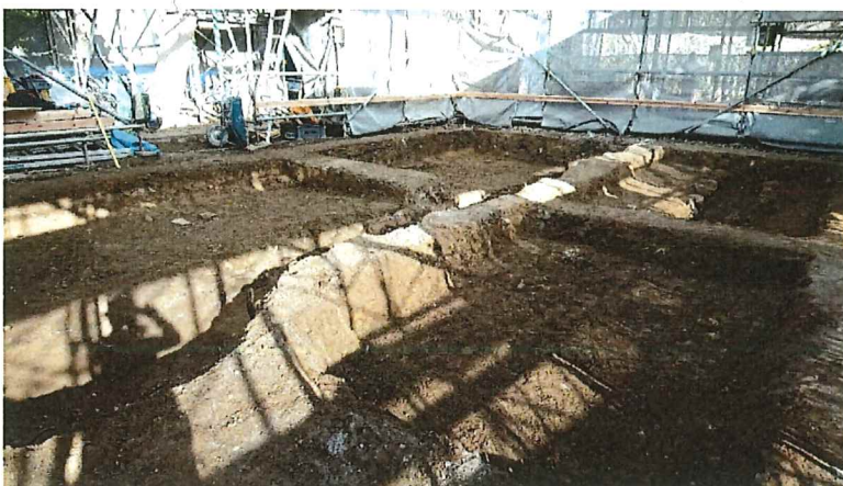
発掘調査風景 （仁王門は修理に伴い解体中）
