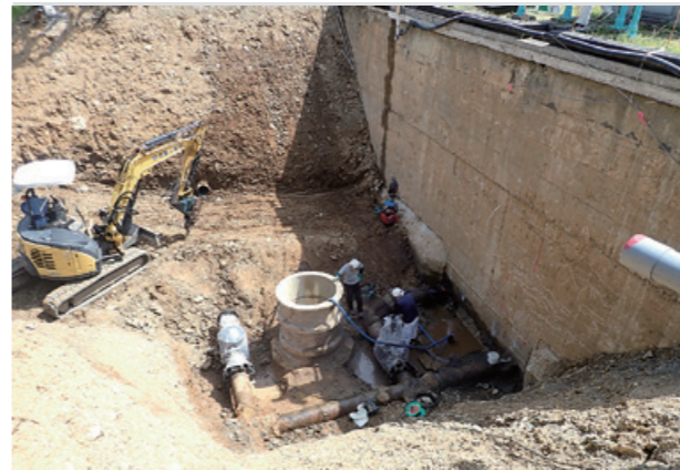
▲配水池から市街地へ配水している水道管の布設替状況
