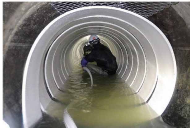
▲老朽化した下水道管を正常に機能できる状態に修復する工事 写真提供：総進・友興特定建設工事共同企業体
