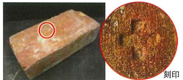
↑JR 舞鶴線白鳥・清道トンネルのれんが (1904(明治 37)年竣工)
