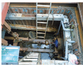
▲既設管を活用し新管を挿入
