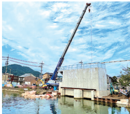
▲高野川流域に新しく雨水ポンプ場を建設
