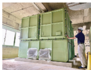
▲汚水処理設備から出る空気脱臭する装置を更新
