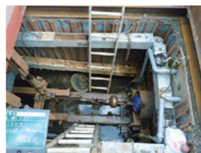
▲既設管を活用し新管を挿入
