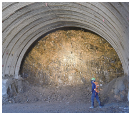
▲掘削している地質の状況
