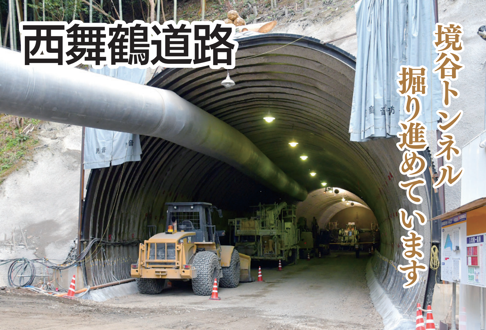
▲境谷トンネル掘削工事
