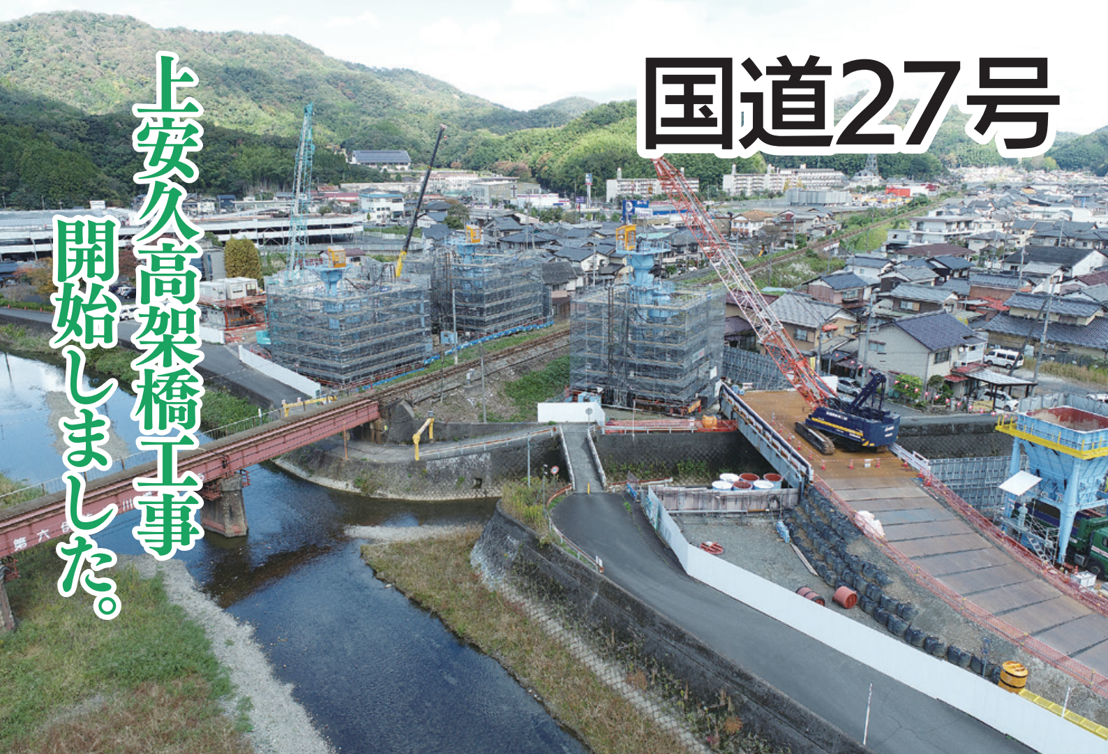
▲上安久高架橋橋脚下部工事（事業者：国土交通省福知山河川国道事務所提供）
