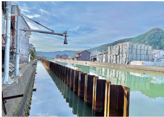
▲工事が進む高野川の護岸
