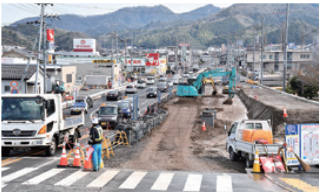
▲二ツ橋付近の4車線工事の様子
