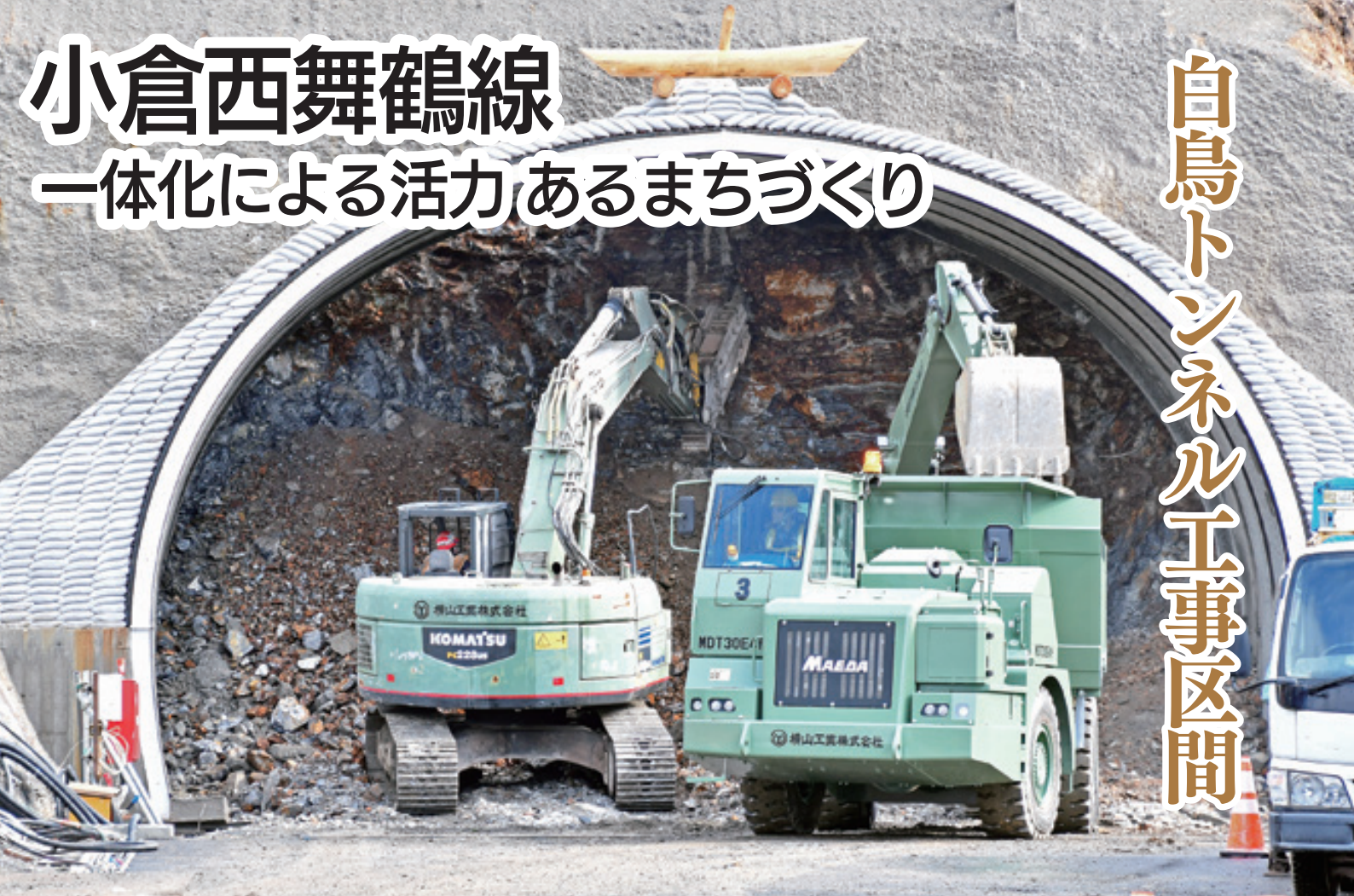
▲新白鳥トンネル（仮称）掘削工事
