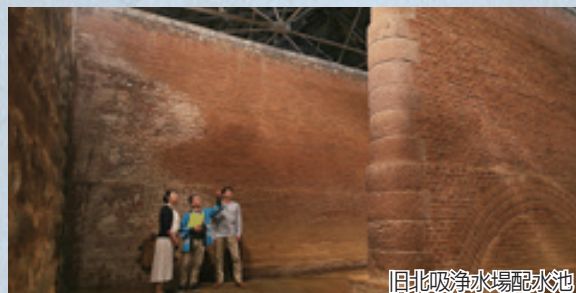
旧北吸浄水場配水池
