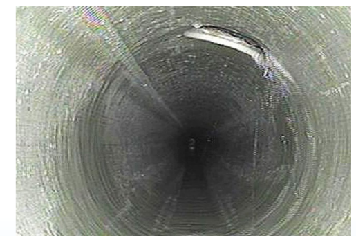
▲工事で修復された下水道管
