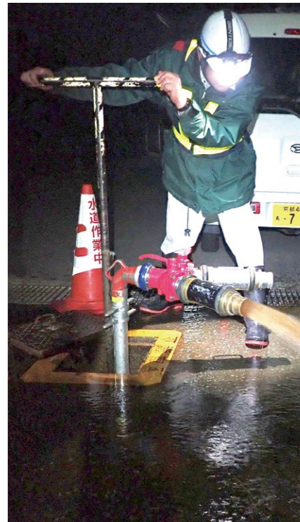
▲水道管の夜間洗浄作業
