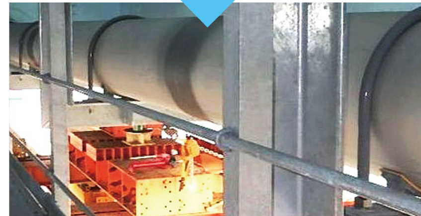
▲橋桁に架設した配水管(直径400 φ )
