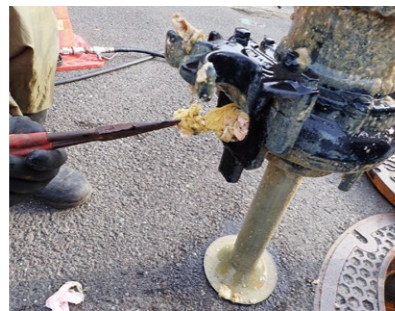
▲ポンプに詰まった異物の除去作業
