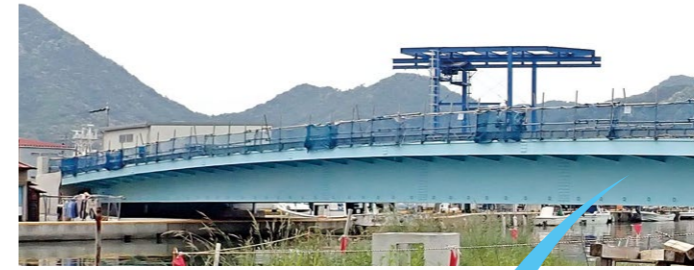
▲京都府が建設中の(仮称)高野川橋りょう(高野川河口)
