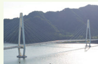
修繕が完了したクレインブリッジ
