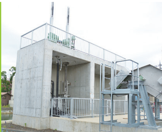
整備中の大手ポンプ場
