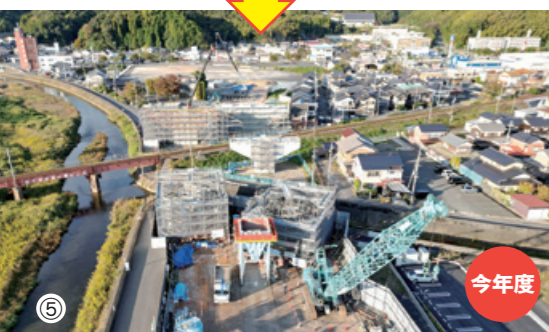
写真④⑤：上安久高架橋橋脚工事 (国土交通省福知山河川国道事務所提供)
