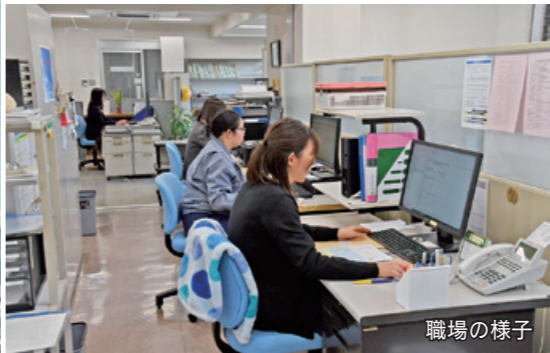
蛍光灯からLEDへの付け替え工事の様子
