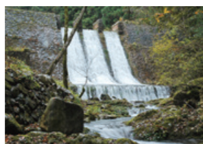
▲1900(明治33)年に築造された桂貯水池えん堤
