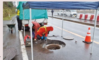
マンホールふた取り替え作業
