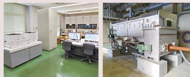
▲東浄化センター 監視制御設備更新
