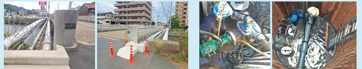
▲祖母谷川に架かる富士通(富士橋)の水管橋架設替
