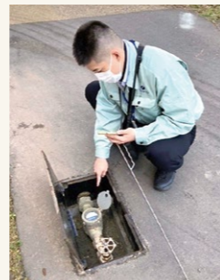
▲水道メーター検針作業
