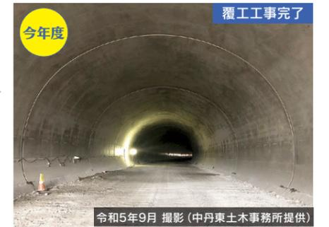
新トンネル内の覆工(トンネル内の内側をコンクリートで覆う)工事が今年度の9月に完了しました。
