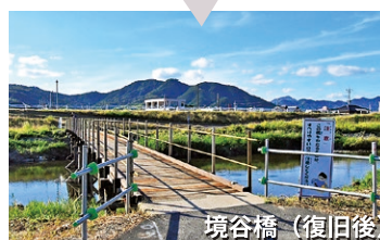
境谷橋 (復旧後)
