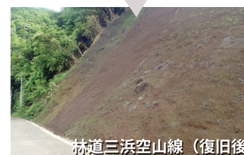
林道三浜空山線 (復旧後)
